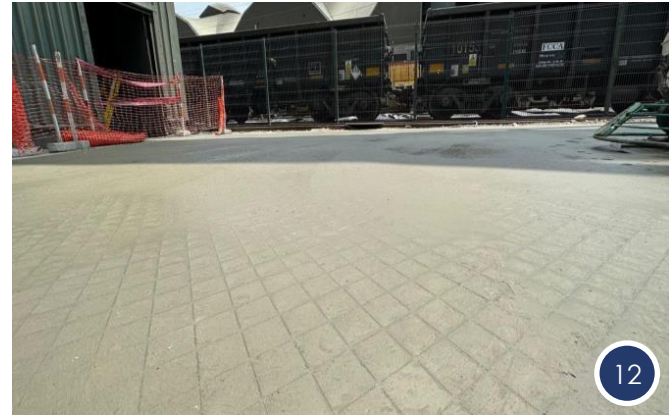
Verificación de acabado
