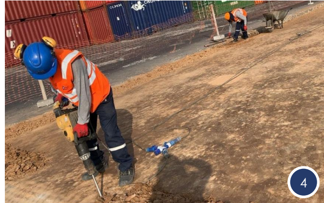
Excavación para viga de concreto y uña
