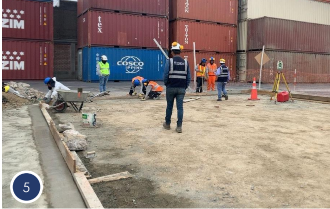
Vaciado de viga de concreto y uña
