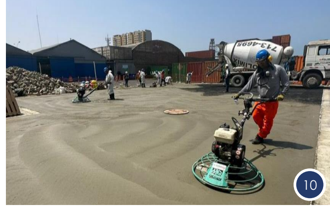
Acabado de la superficie
