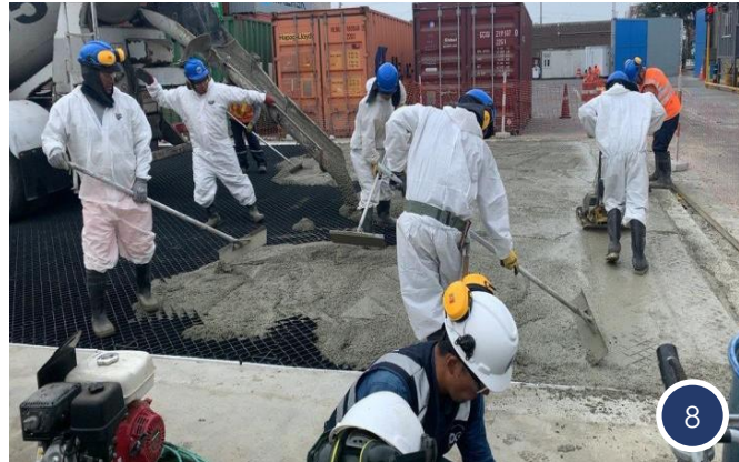
Vaciado de concreto en Geogrid DG+
