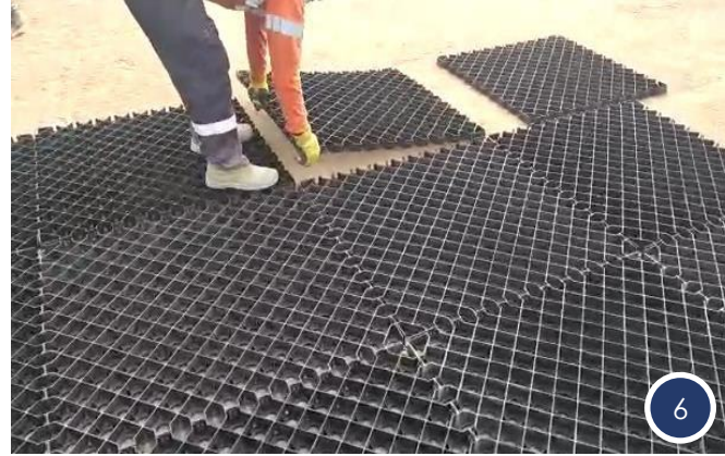
Instalación de Geogrid DG+
