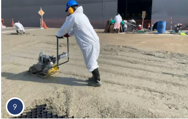
Vibrado de losa con Geogrid DG+
