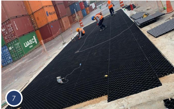
Fijación de Geogrid DG+
