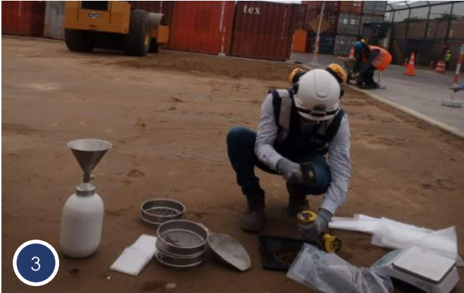
Control de compactación
